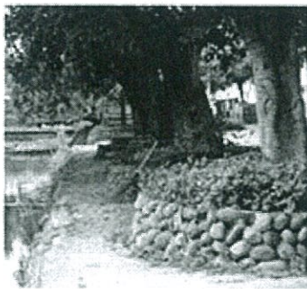
砌石擋土牆 (案例)
